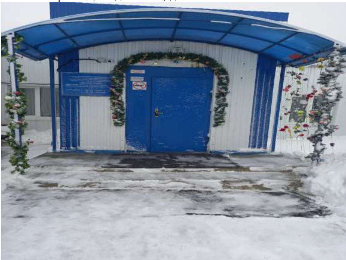
Фото № 1 Крыльцо, входная площадка
