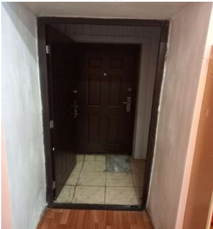
Фото № 7 запасной выход
